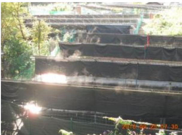
手前が発電施設① 奥が発電施設②
