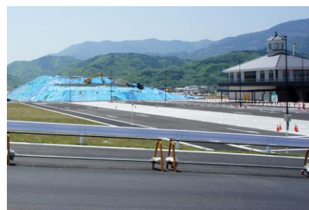
富士川町の工事現場
